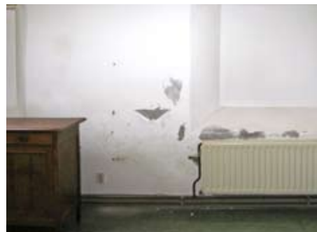
Stucwerk dat loslaat
