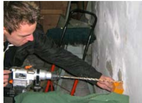
Gaten boren op drie hoogtes
